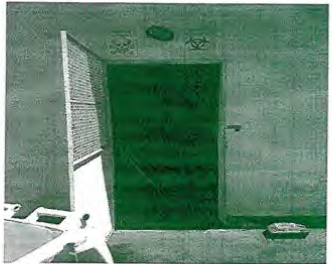
Foto 10: Abrigo Resíduo - Perfuro cortante.
