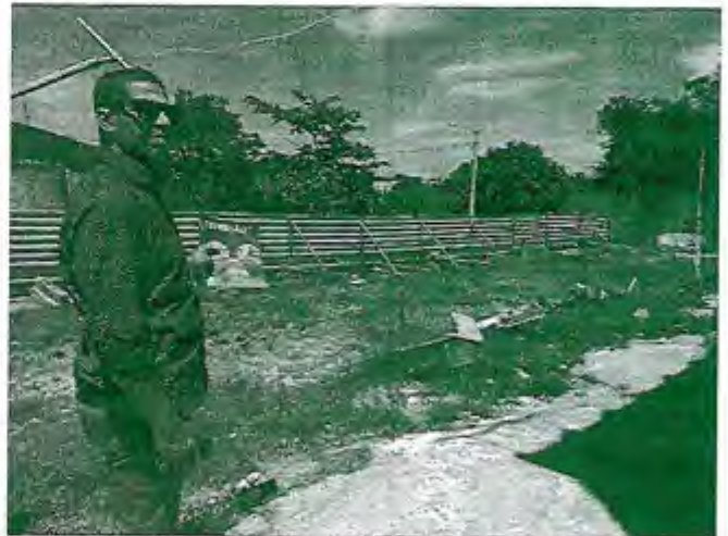
Foto 4 : Área Externa – Fundos do Hospital.
