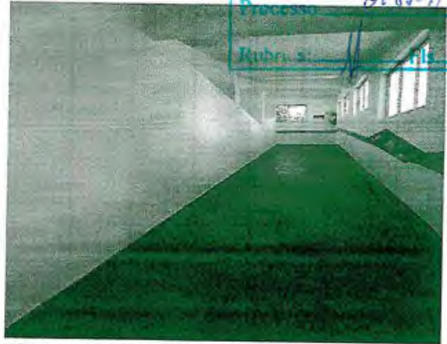
Foto 14: Limpeza e pintura corredor 1º pavimento.
