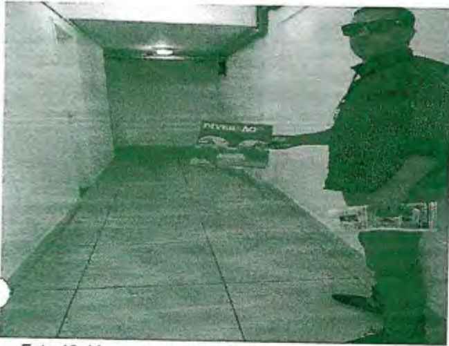
Foto 13: Limpeza e pintura área Interna.
