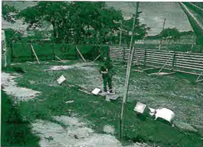
Foto 5 : Área Externa – Fundos do Hospital.
