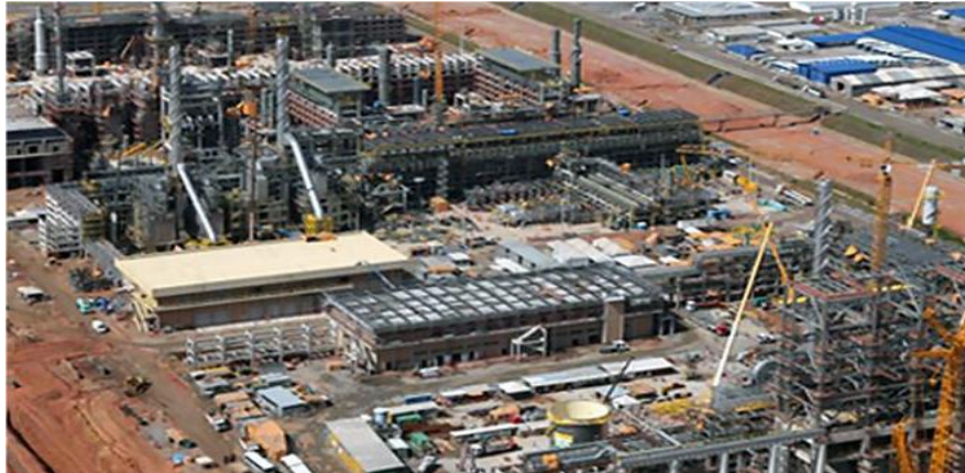
Figura 3 – Área de construção da UPGN.
